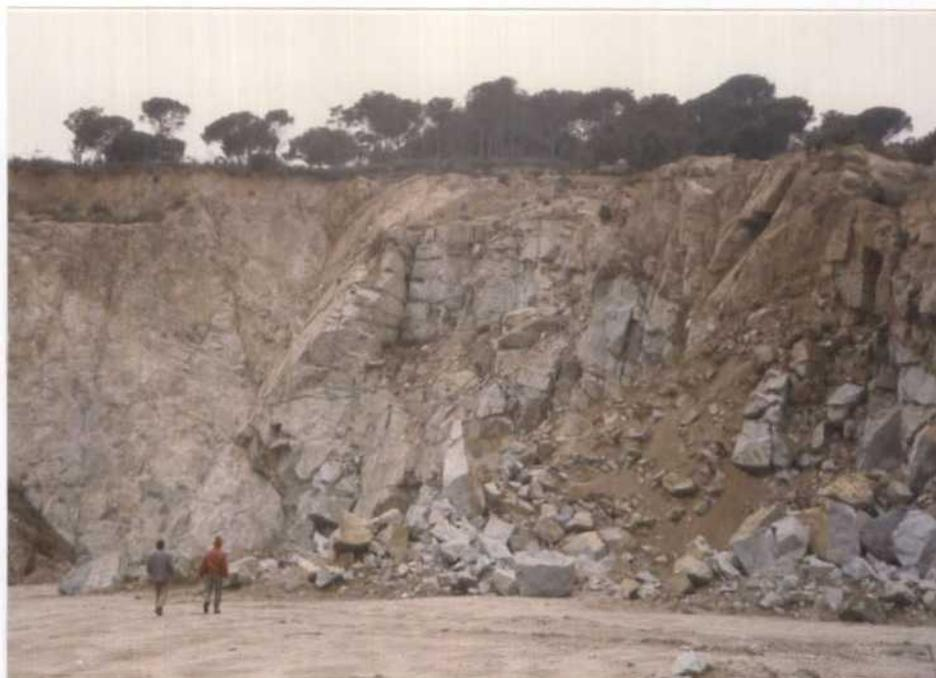
Foto 59 (70/K12).- Hoja 393. Cantera para la obtención de áridos y bloques de escollera en las proximidades de Dosrius. Indicio 393-6.
